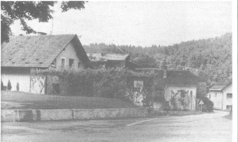
Preserje: Zgledno udarništvo in slaba voda
