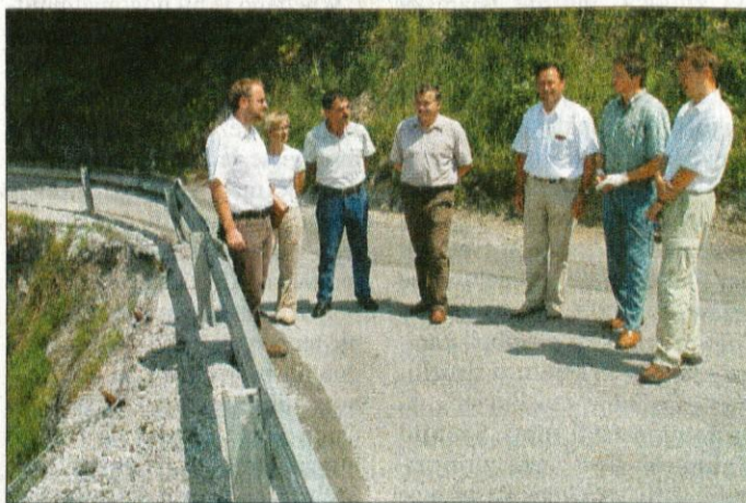
Po sestanku so si udeleženci ogledali poškodbe ceste v Dolino.
