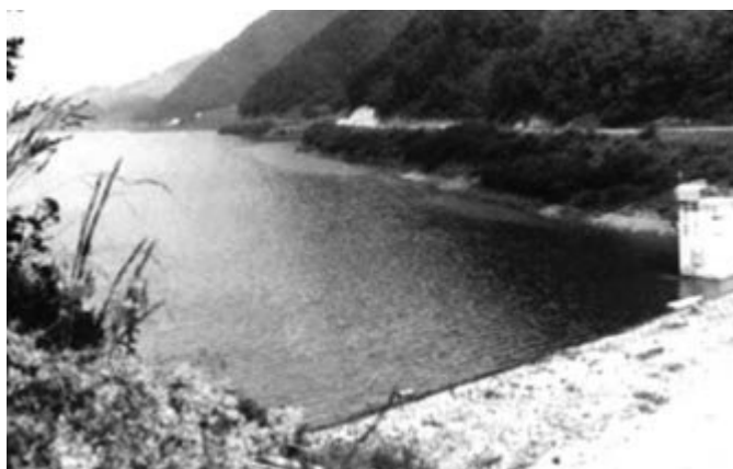
Slika 1 • Vonarska pregrada v 80. letih (Arhiv čuvaja pregrade Vonarje)
