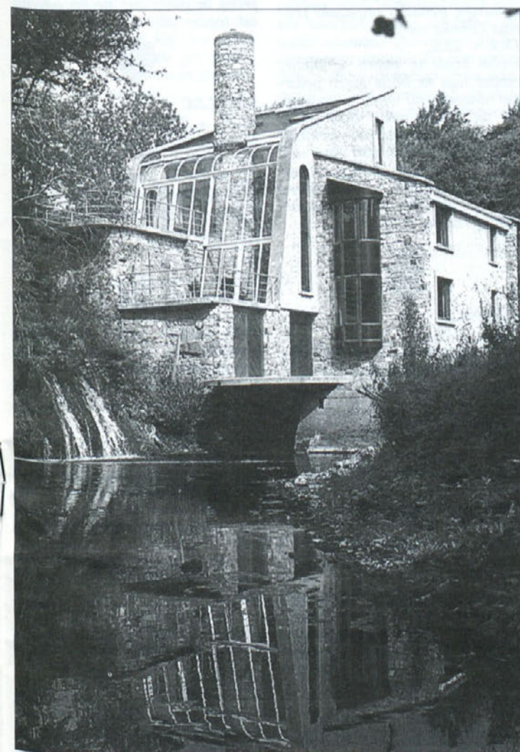
Hiša Charlesa Coughlana v Meathu na Irskem, zgrajena nad starim mlinom v bližini slapa, dobro izkorišča svoj sijajni položaj. Zastekljena stran se odpira na terase z napušči, ki se spuščajo k jezu. Pasivna sončna toplota se kopiči v masivnem kamnitem zbiralniku, dodatno energijo pa zagotavlja turbina, ki jo poganja kolo starega mlina. Arhitekt: Paul Leech, Združenje Gaia, Irska.
