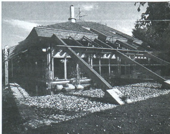
Za izhodišče te hiše v Linzenbachu v Nemčiji so bili ogenj, voda in zemlja. Voda obkroža bivalni prostor, streha je pokrita s prstjo, ogenj pa je v osrednjem zbiralniku. Arhitekt: Horst Schmitges.
