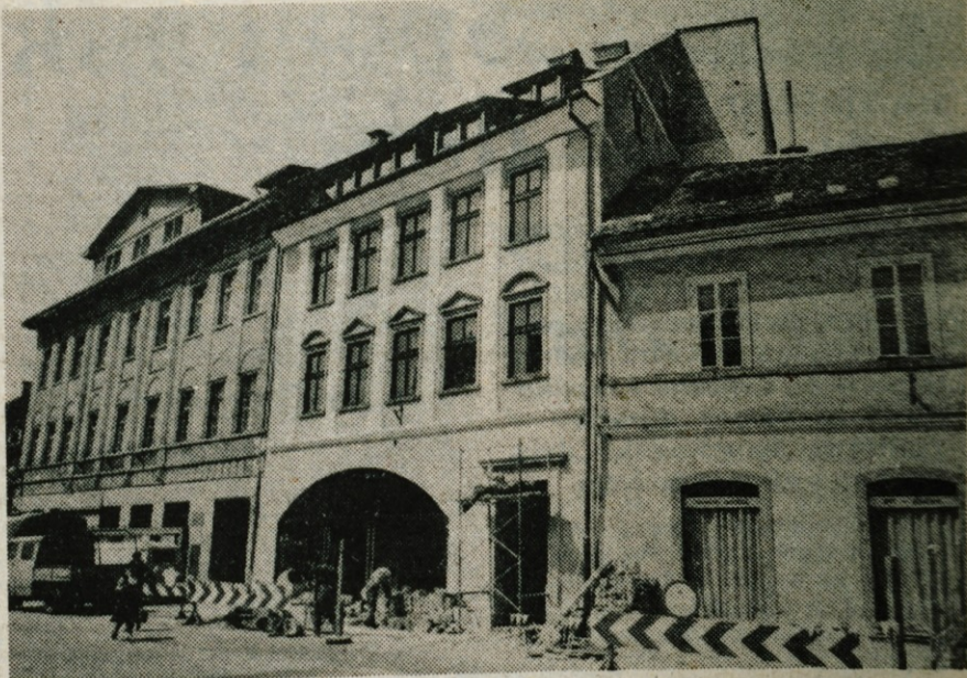
V program revitalizacije starega mestnega jedra Kranja sodi tudi stavba na Maistrovem trgu, kjer se dolgotrajna dela zdaj bližajo koncu. — Foto: F. Perdan
