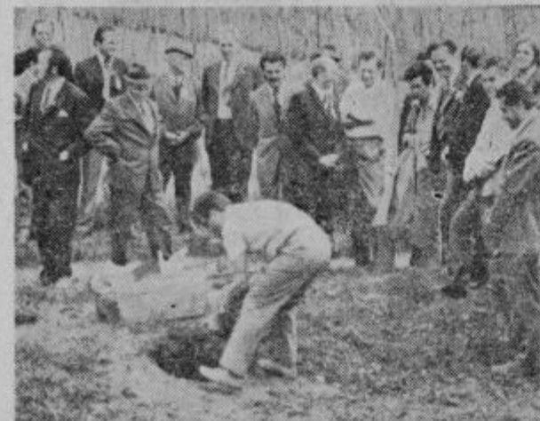
Na kraj, kjer so pred dnevi položili temeljni kamen za izgradnjo mostu, je z Bučami pobratena krajevna skupnost Vodmat iz Ljubljane že pripeljala izlezne opornike in bo kmalu pričela z delom.
