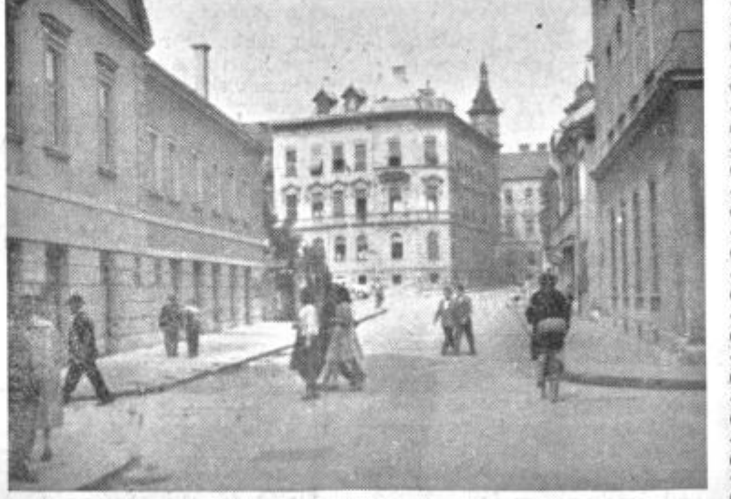
Nov pogled na Gubčevo ulico v Celju
