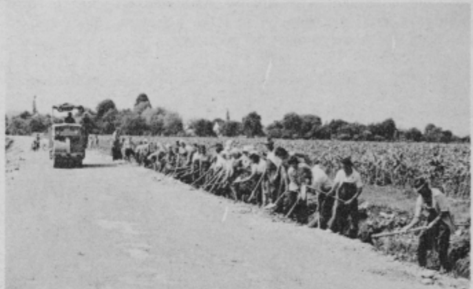
Vaščani Sp. Velovlaka pri modernizaciji ceste Podvinci-Sp. Velovlak.
