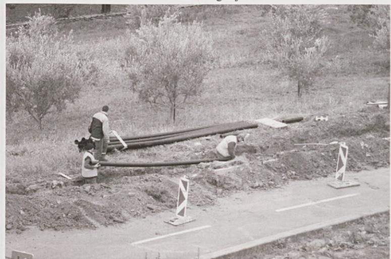
Delavci polagajo cevi za optične kable v Luciji.
