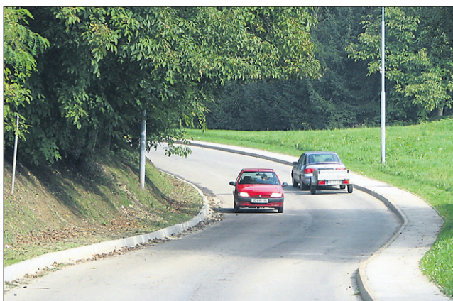
Robnik na cesti proti Lešnici je po Kosijevih trditvah nevaren, saj onemogoča srečanje dveh tovornih vozil.
