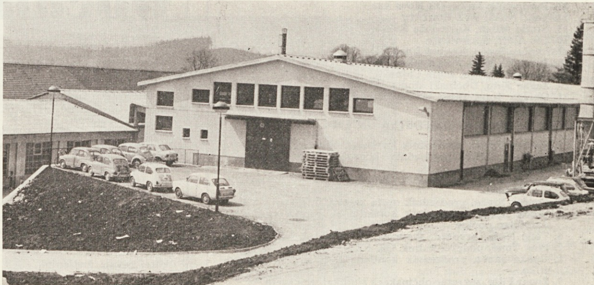
Nova proizvodna hala KARTONAŽE na Rakeku
