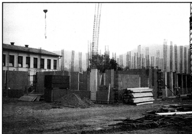
Gradnja nove šole napreduje v skladu s terminskim planom (foto: F. Kotnik)
