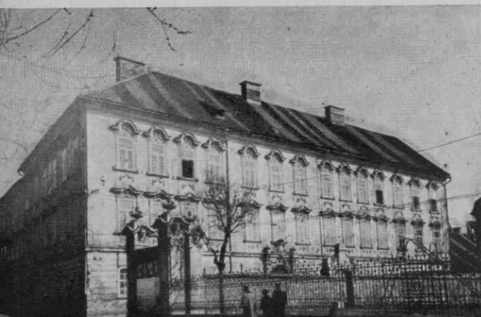
Sl. 1. Gruberjeva palača — zahodna fasada
