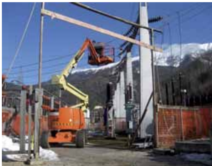
Demontaža starega polja.
