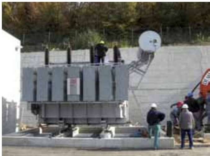
Postavljanje transformatorja.
