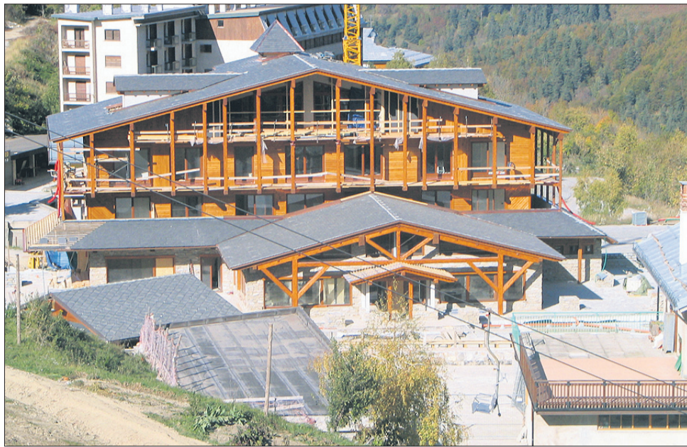
Za hotel, ki so ga Biva hiše gradile v Italiji in s katerim so si pri drugih kupcih pridobile reference, je vso jekleno konstrukcijo izdelal samostojni podjetnik Dušan Urankar. V hotel je vgrajenih 63 tisoč ton jekla.
