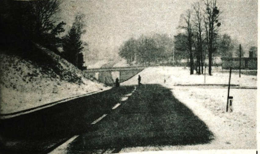
Novo radovljiška obvoznica - Ob 29. novembru so odprli v Radovljici novo obvoznico Radovljica-Lancovo, ki bo precej razbremenila promet v lipniško dolino. Obvoznico je financirala komunalna skupnost Radovljica skupaj z republiško skupnostjo za ceste, podvoz pod železniško progo pa tudi železniško gospodarstvo. Republiška skupnost za ceste je obvoznico namenila denar iz viška posojil za ceste. - Foto: D. Kuralt
