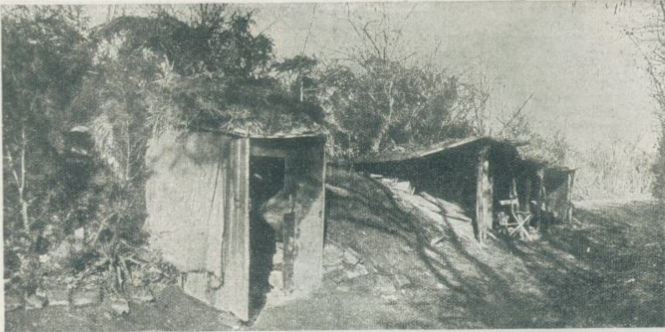
Utrdbe ob Savi. Vhodi k srbskim podzemnim zakopom ob obrežju Save.
