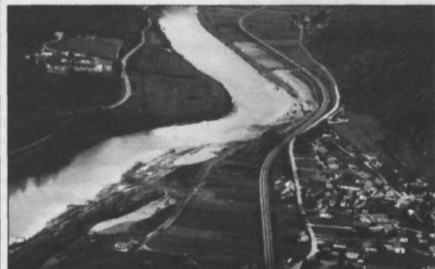
Pogled na del akumulacijskega bazena HE Blanca
