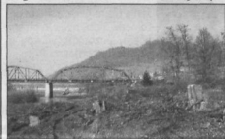
Urejanje brežin in izkop gramoza, Sevnica, levi breg Save
