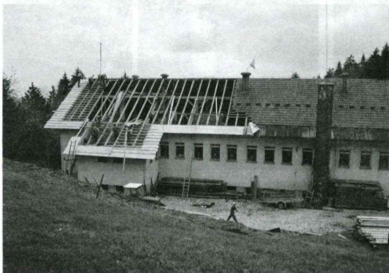
Prenova šolske strehe.
