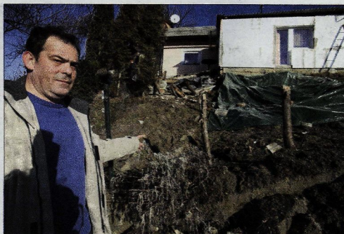
Plaz pri Podgorškovihi si je včeraj ogledal geomehanik Andrej Blažič, ki je potrnil, da bivanje v hiši zaradi plazena zemlje ni varno.
