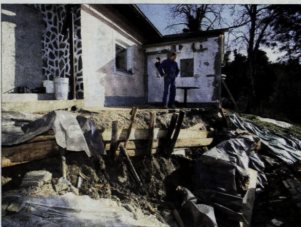
Drsena zemlja ne zaustavijo niti zaščitni piloti niti folija.
