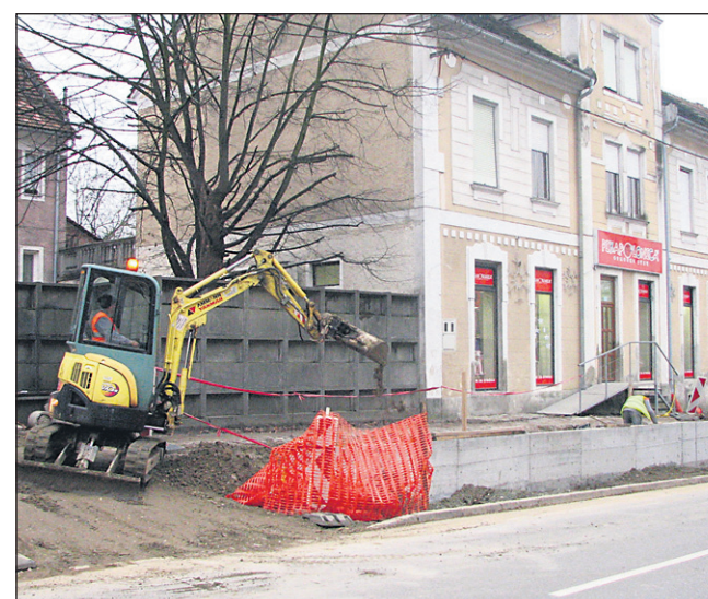
Promet skozi center Ormoža je nekoliko otežen, ker poteka obnova Kerenčičevega trga.
