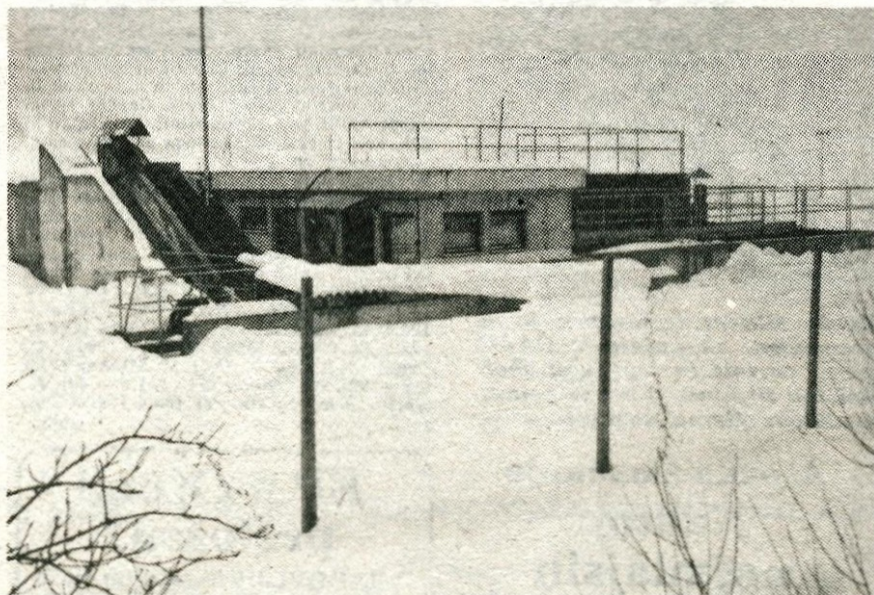
Letos so delovne organizacije iz Železnikov zgradile čistilno napravo
