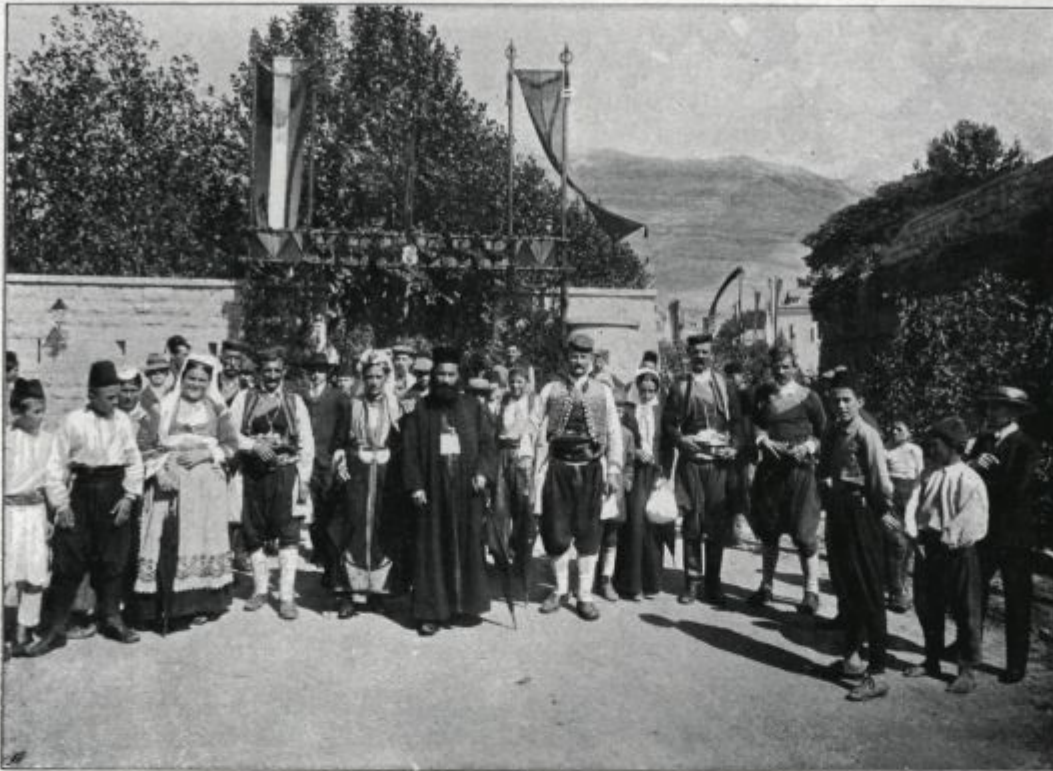
BOSNJAKI PRIČA- KUJEJO PRVEGA VLAKA NOVE ŽELEZNICE.
