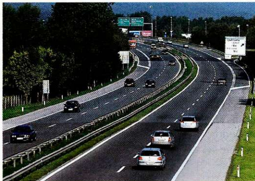
Največ cest bo letos dokončanih v Pomurju.
