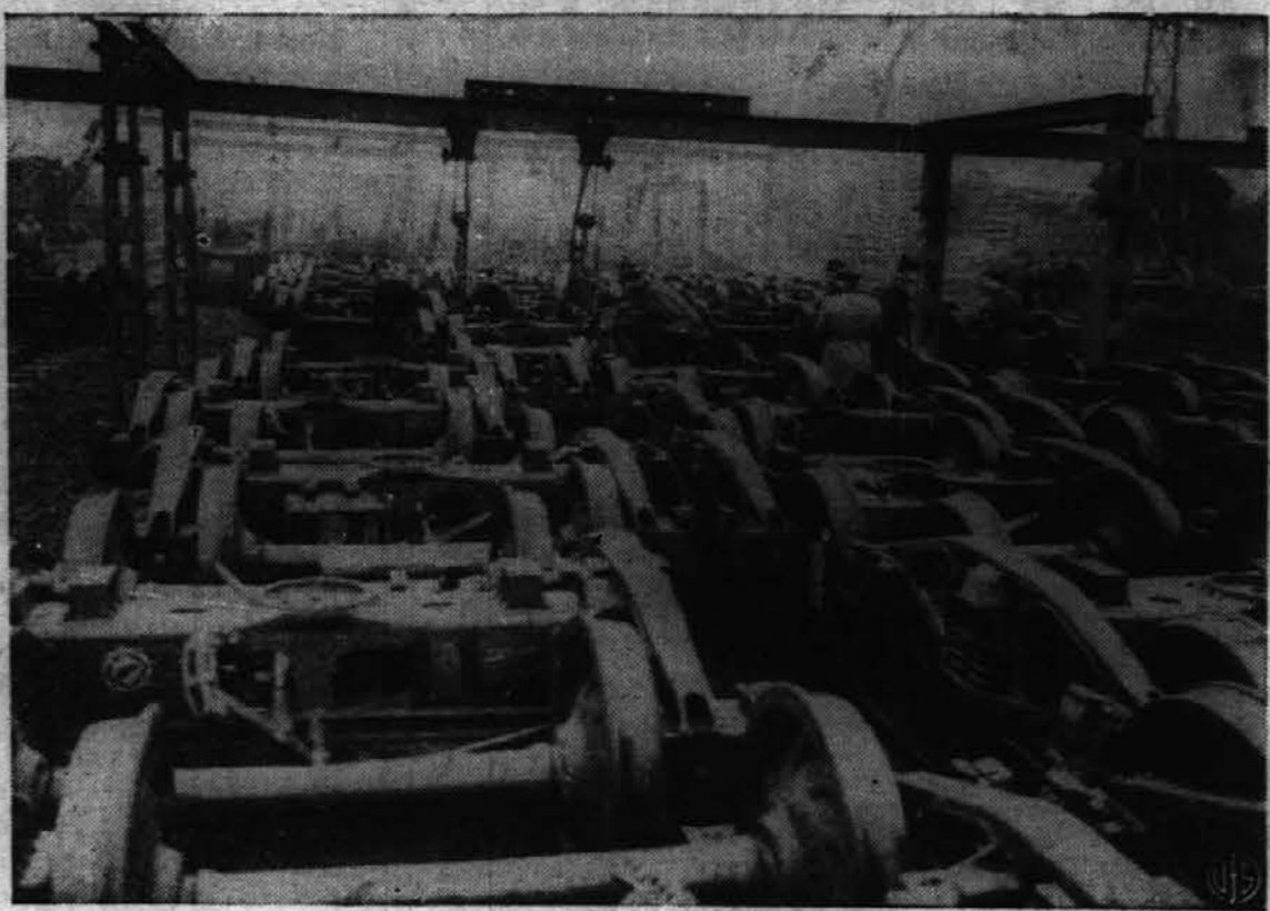
Ena ismed tisoč podrobnosti, ki jih je treba pripraviti za evropsko invazijo, je izdelovanje železnih vozov, ki bodo tekli po nemških tračnicah. Na sliki vidimo, kako osebe od U. S. Army Transportation Corps neke v južni Angliji zlaga in sestavlja posamezne dele, ki so bili napravljeni v Ameriki.
