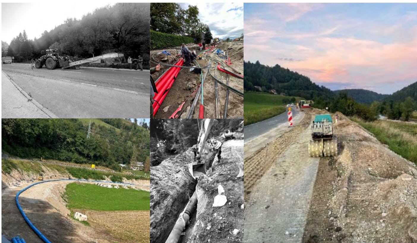
Slika 17: Freziranje izkopa za polaganje cevovoda na trasi prvega projekta
