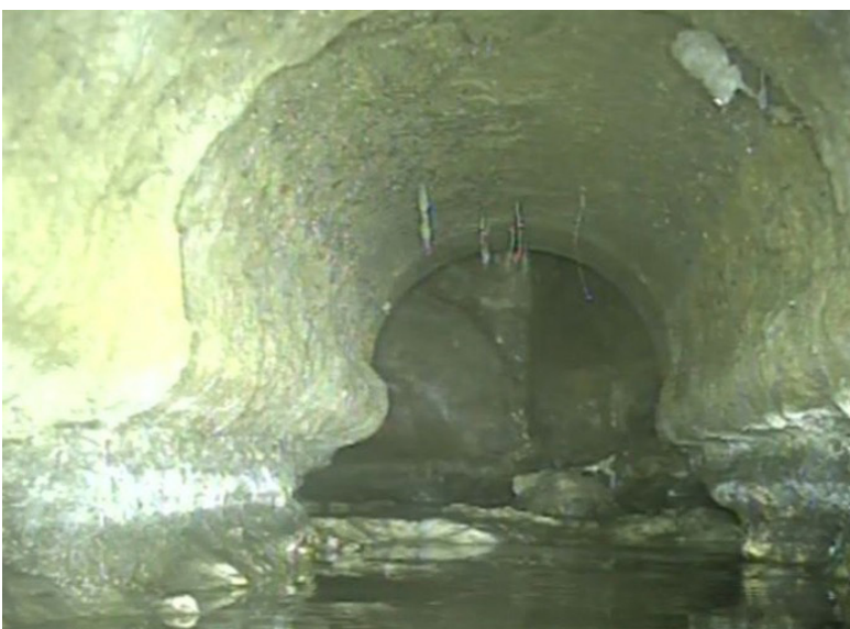
Slika 7. Primer kanalizacije brez dna Vir: VODOVOD - KANALIZACIJA, d. o. o.
