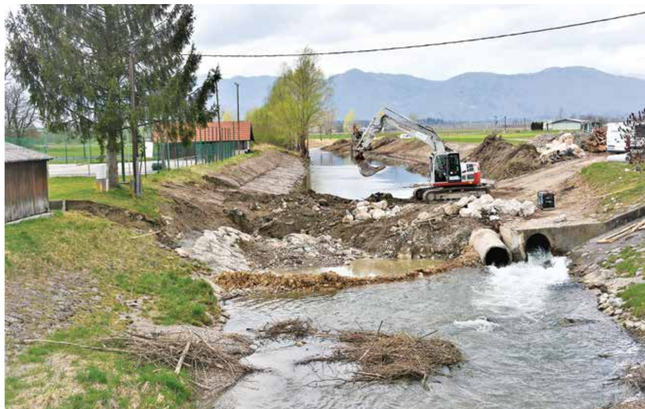
Pri sanaciji je odstranjen mehki jez, zgradila pa se bo kamnita drča.
