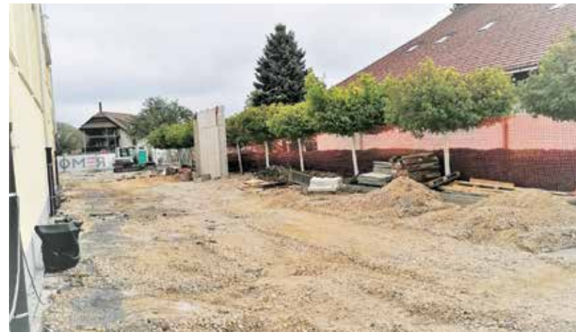
Pred šolo je spet gradbišče.
