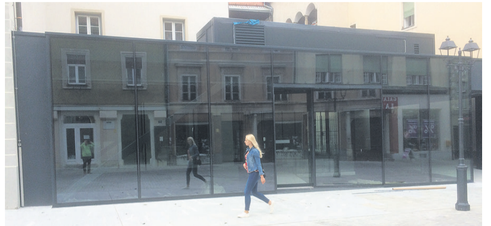
Že skoraj končani prostori novega Turističnoinformacijskega centra na Glavnem trgu v Celju.
