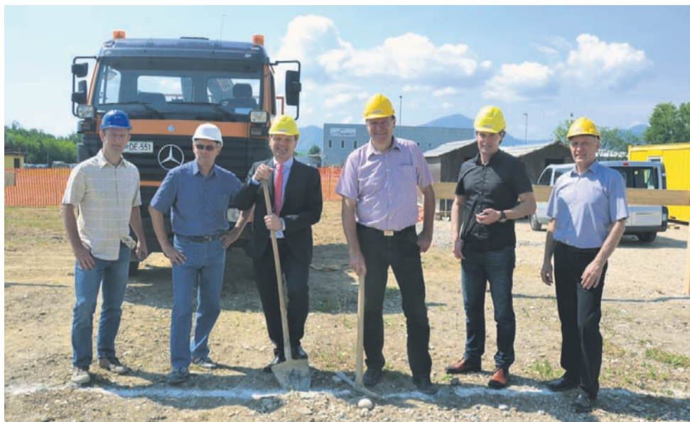
Prve lopate na gradbišču v neposredni bližini obstoječe tovarne so gradbeniki in vodstvo podjetja že zasadili. Nova hala naj ni na tem mestu zrasla do konca novembra. Nove sodelavce bo direktor Matjaž Omladič začel iskati prihodnje leto. Obeta se do 150 novih zaposlitev. (Foto: LK)
