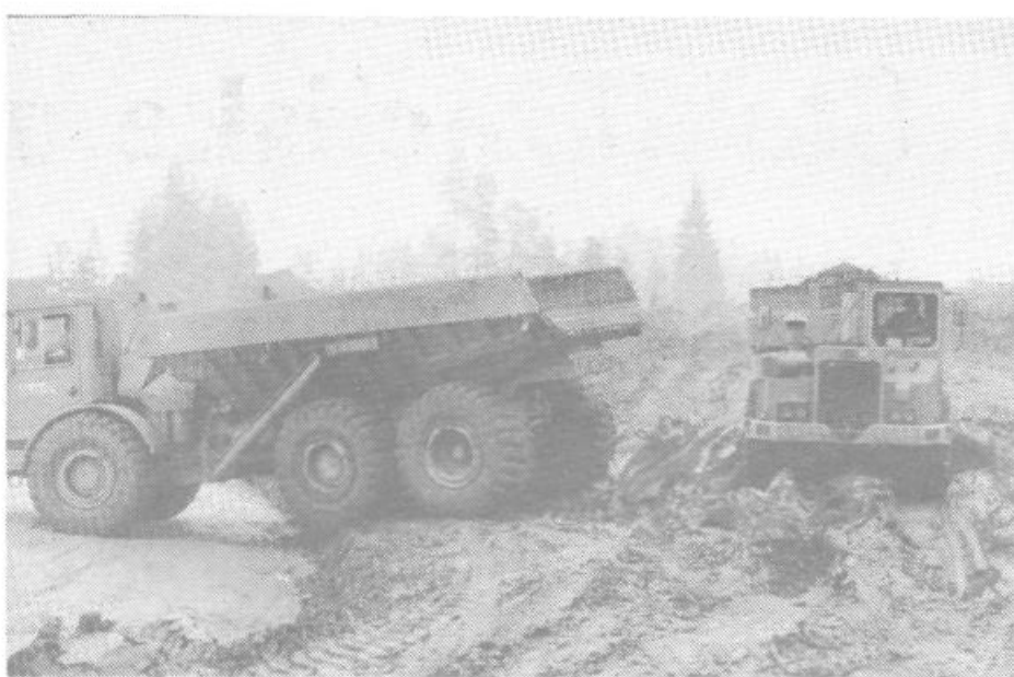
Dela na zahodni mestni obvoznici potekajo po predvidevanjih!
