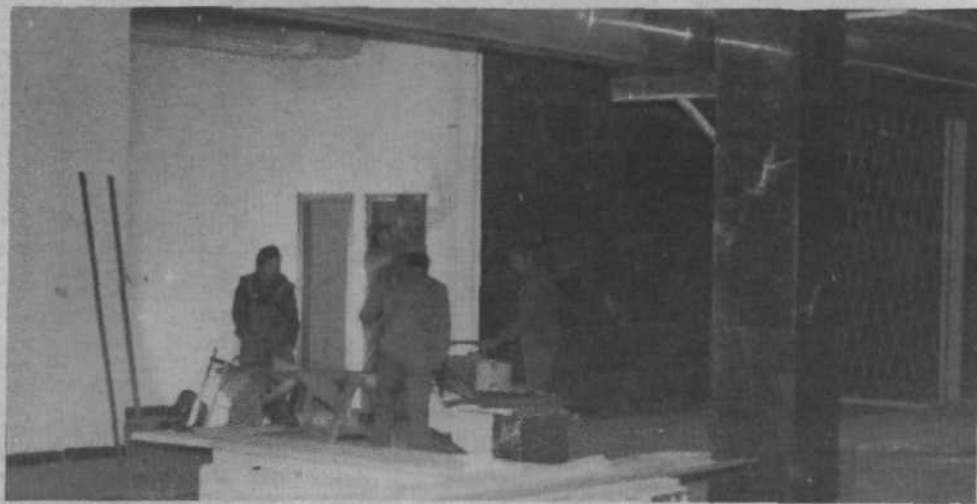
PRI TRŽNICI SE ŠE ZATIKA – Vse kaže, da bo bežigradska tržnica, v podzemlju pred Plavo laguno, kmalu nared. Na gradbišču je živahno, seveda pa ne gre brez zapeljajev. Gre predvsem za bodoče uporabnike, organizacije združenega dela, ki sami financirajo opremo prodajnih prostorov: opremo so prepoznali. Februarja je predviden tehnični pregled objekta, do takrat pa bo verjetno znan tudi datum uradne otvoritve nove bežigradske tržnice.
