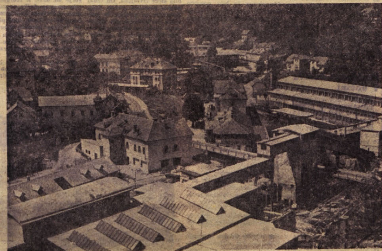
Rudarsko naselje Toplice — dobro je viden tudi del rekonstruiranih objektov za novo separacijo
