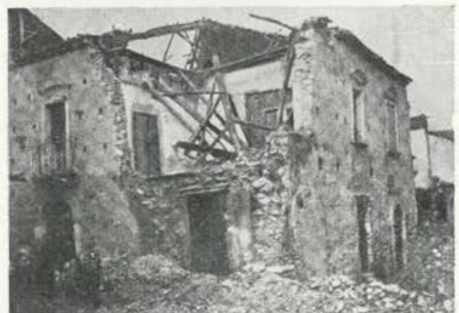
Učinek potresa na stavbe (Geminara v Kalabriji po potresu l. 1894)
