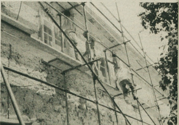
DEL GRADU KAŽE REBRA - Hkrati z ustavitvijo poljenja južnega grajskega vogala bodo obnovili tudi fasado na južnem krilu metliškega gradu. Zato morajo zidarji najprej odbiti staro fasado, pod katero so se prikazala zanimiva odkritja. (Foto: M.B.-J.)
