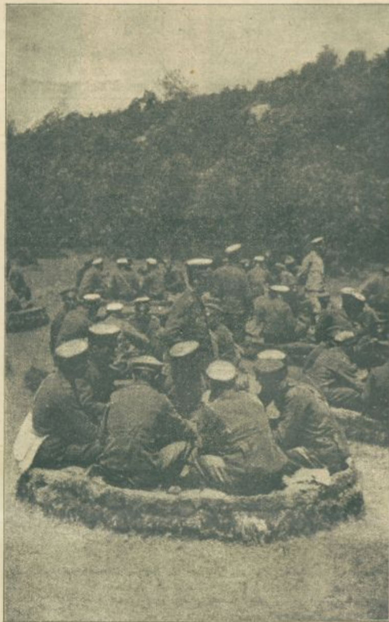
Bulgarski vojaki obedujejo v napravljenih ruševinah.
