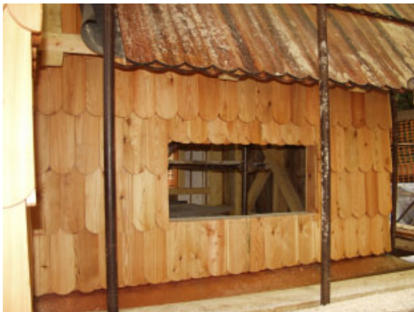
Slika 11 Nove fasadne obloge na zvonikih in ladji kapelice (foto arhiv ZVKDS).
