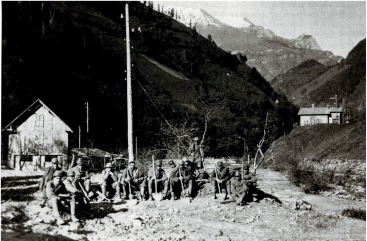
Slika 62 Ruski vojni ujetniki pri gradnji oz. popravilu ceste pri Hudajuzni (iz arhiva Ivana Lesjaka).
