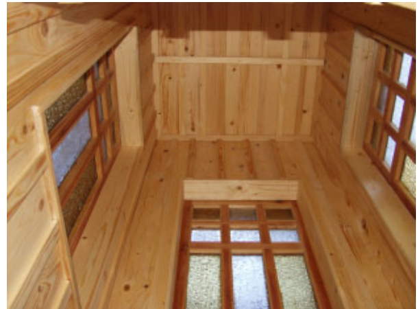
Slika 10 Notranjost zvonika kapelice, nosilna konstrukcija in končni videz (foto arhiv ZVKDS).
