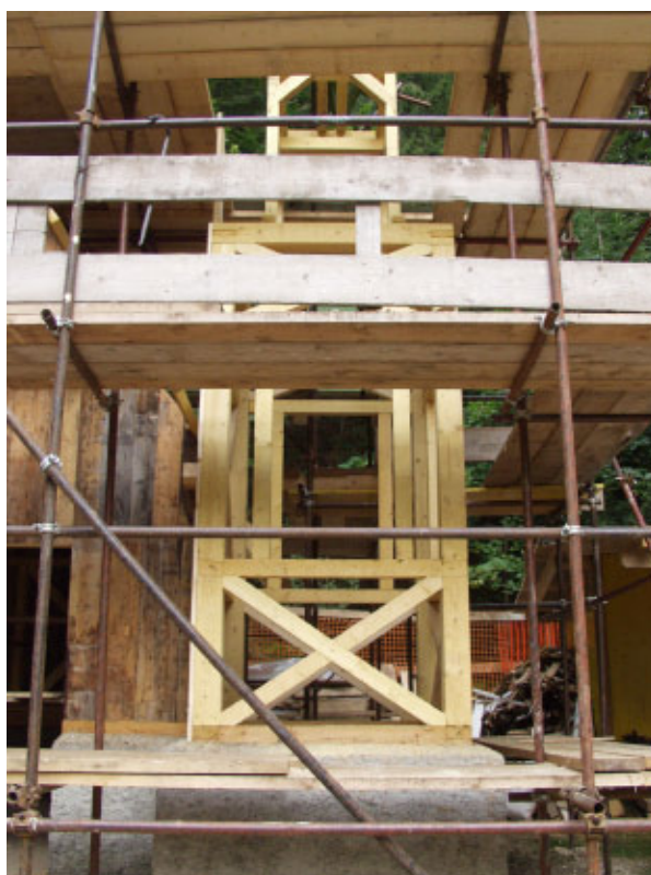
Slika 7 Obnovljeno podnožje zvonika in nova nosilna konstrukcija zvonika (foto arhiv ZVKDS).
