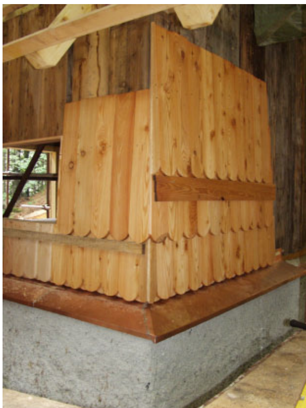
Slika 8 Nove bakrene pločevinaste obrobe na kapelici (foto arhiv ZVKDS).
