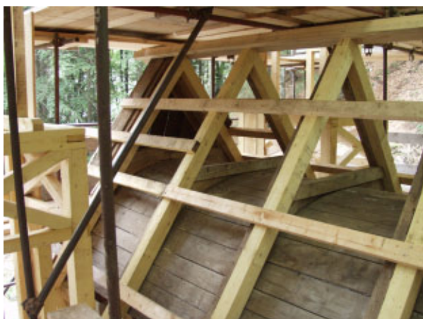
Slika 6 Kapelica v fazi demontaže elementov z obratitvijo stropa nad ladjo kapelice (foto arhiv ZVKDS).
