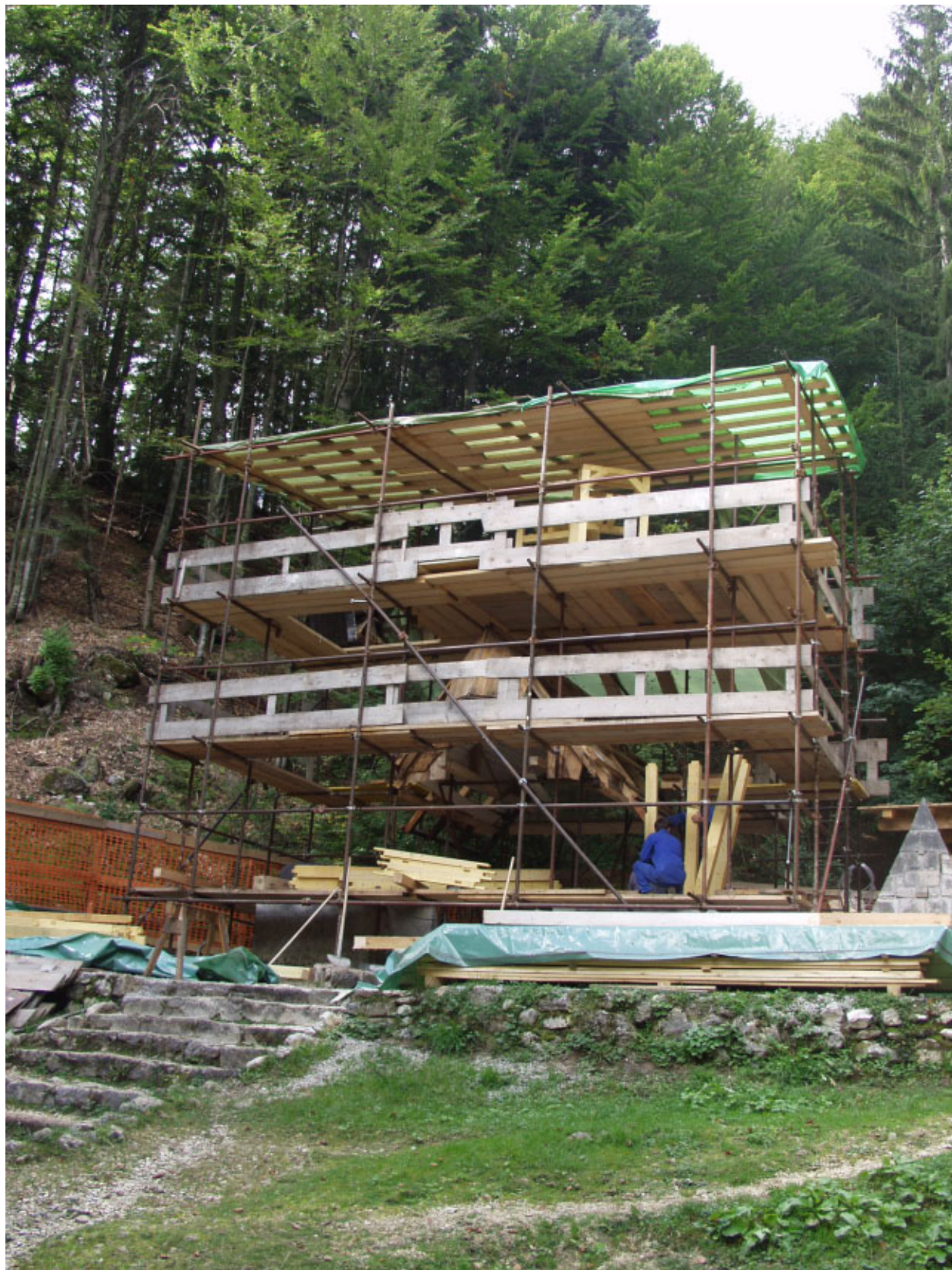
Slika 5 Delovni odri in začasna nadstrešnica med prenovo kapelice (foto arhiv ZVKDS).
