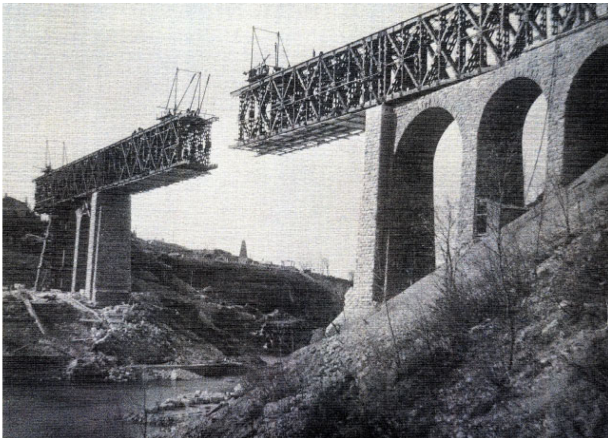
Slika 6 Obnova Solkanskega železniškega mosta s postavitvijo Roth-Waagnerjeve kovinske konstrukcije leta 1918 (po Schaumann 1991, 190).
