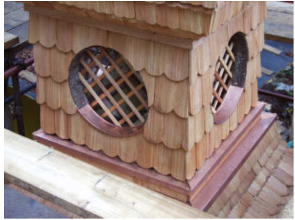
Slika 14 Detajli izvedbe zvonika z novima okroglinama (foto arhiv ZVKDS).
