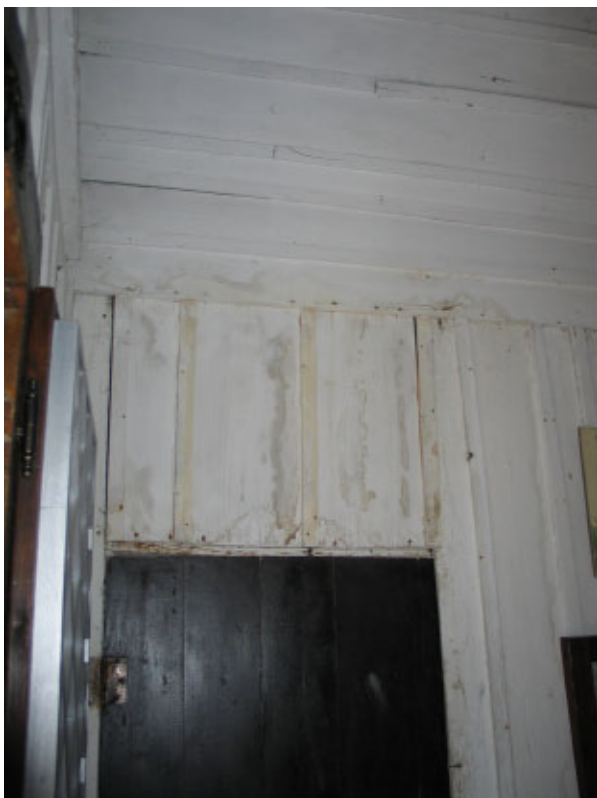
Slika 2 Propadanje lesnih oblog v notranjost zaradi stalnega zamakanja na obeh zvonikih (foto arhiv ZVKDS).
