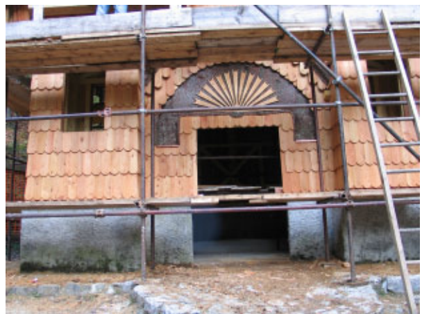
Slika 15 Ponovna izvedba vseh detajlov nad vhomom v kapelico (foto arhiv ZVKDS).
