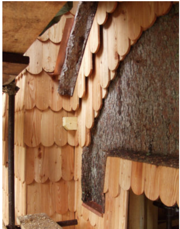
Slika 14 Detajli izvedbe zvonika z novima okroglinama (foto arhiv ZVKDS).
