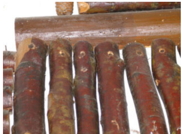
Slika 3 Poškodbe enostavnih lesenih gradnikov oltarja in dveh malih oltarnih miz (foto arhiv ZVKDS).
