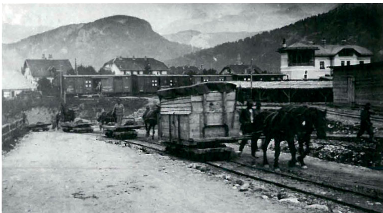
Slika 50 Konjska vleka na ozkotirni železnici med Bobinjsko Bistrico in Ukancem. Na drugem transportnem vagonu sta dva ruska ujetnika pri delu (po Grdina, Pagon 2016, 65).
