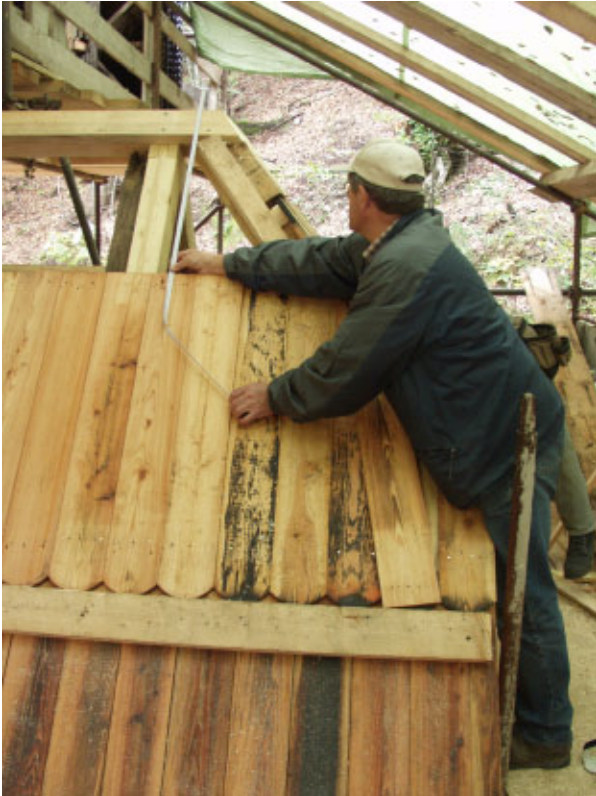
Slika 13 Prekrivanje strehe kapelice z macesnovimi deskami (foto arhiv ZVKDS).
