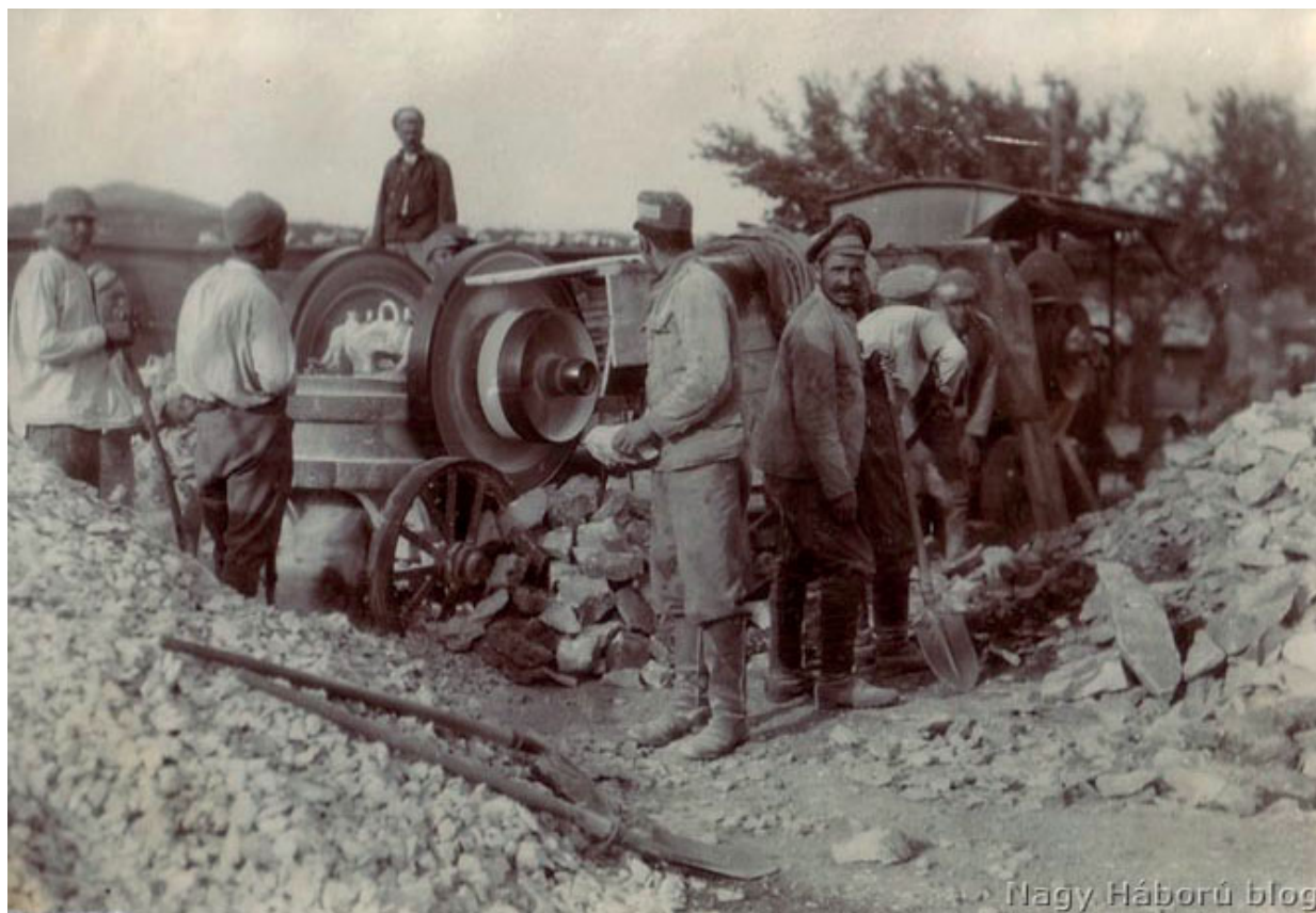
Slika 131 Ruski ujetniki na območju tabora pripravljajo material za gradnjo ceste (po Splet 19).
