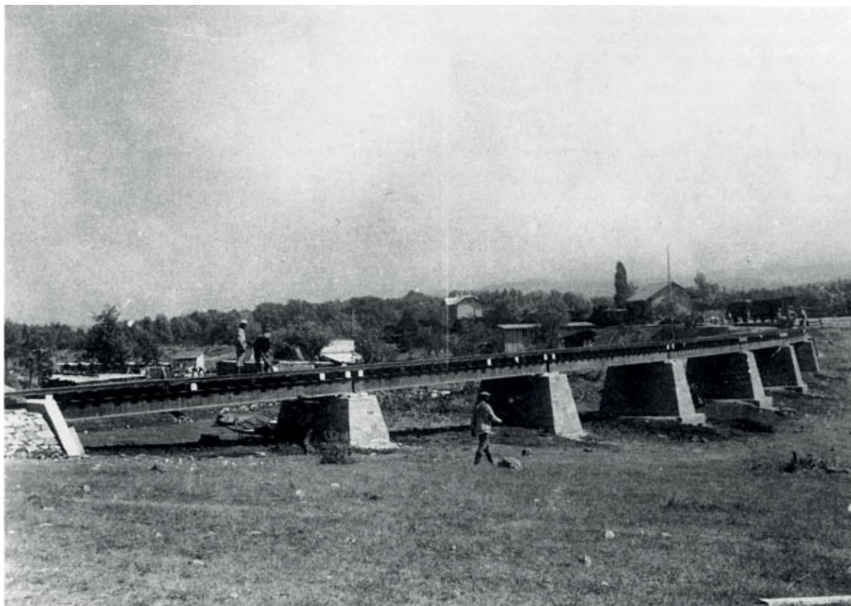
Slika 139 Izvozni tir železnice iz železniške postaje Dutovlje/Skopo je skupaj s 35. železniško četo gradilo več železniških delovnih oddelkov vojnih ujetnikov od 15. avgusta do 3. septembra 1915 (po Schaumann 1991, 161).
