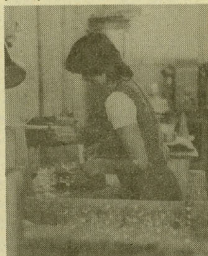
Vrivanje grl steklenic je z novim diamantnim strojem produktivnejše - foto Z. Novak
