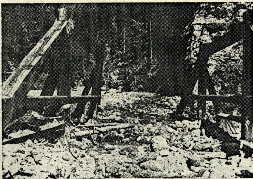
Hudournik Belca spreminja strugo. Obsežna in draga gradbena dela bodo le začasno rešila uporabnost mosta - foto GG Bled
