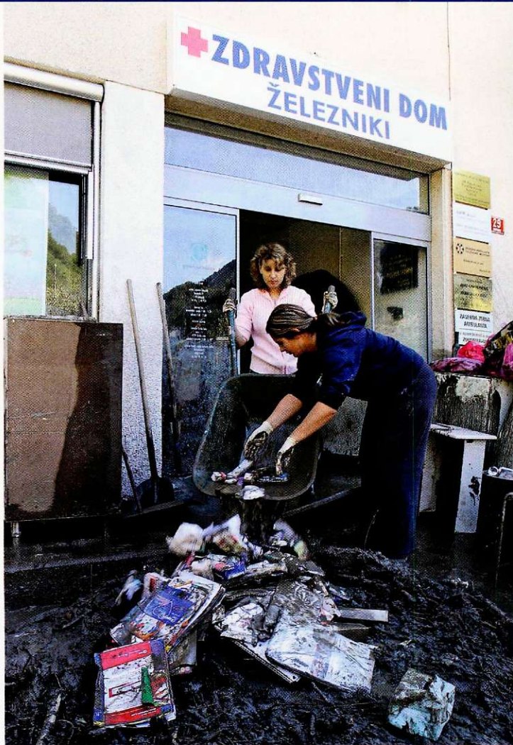
Zdravstveni dom v Železnikih je bil zaradi visoke vode neuporaben.
