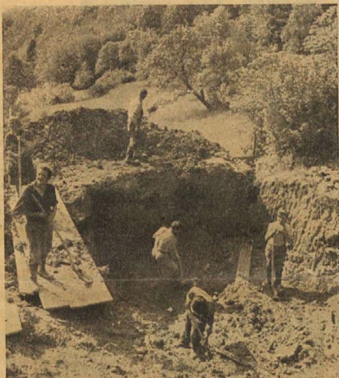
Občani Klopce in Vrha pri gradnji vodovoda
