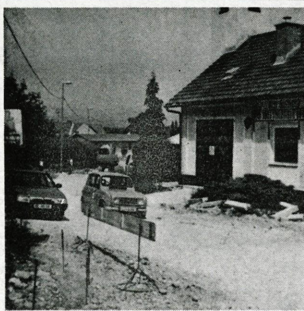
Potem ko so jo krajan pred nedavnim zaprti, so prejšnji teden začeli obnavljati regionalno cesto v Valburgi.
