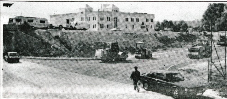
Za ta mesec je napovedana izgradnja priključka pri nogometnem igrišču.
