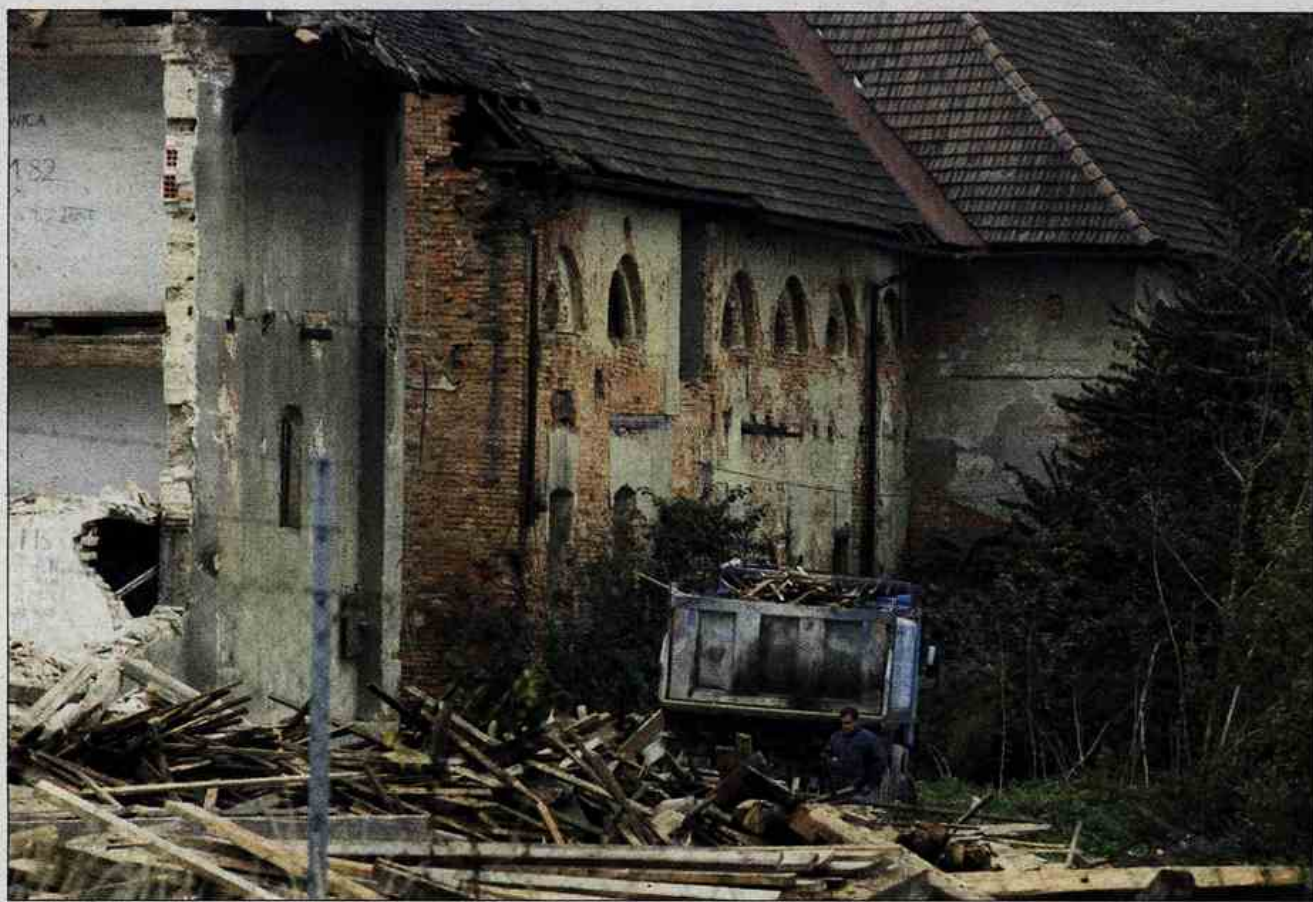
Na ministrstvu za obrambo pravijo, da imajo vsa soglasja za rušenje.
