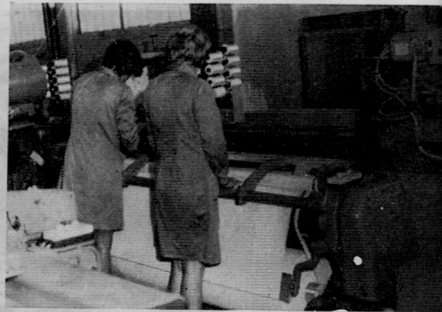
V novi hali tkalnice se nadaljuje montaža brezčolničnih tkalskih strojev SAURER — VERSAMAT. Nekaj statev že obratuje.
