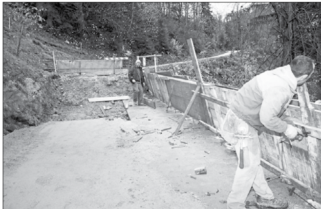
Za sanacijo plazu pod cesto Zavodice-Čreta so porabili okoli 500 kubikov betona in okoli 10.000 kg železne armature. (Foto: Marija Lebar)
