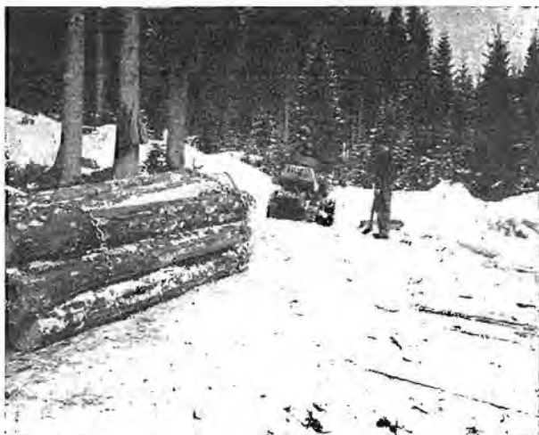
Slika 2. Zbiranje lesa z vitlom do traktorja (foto: Krivec)
