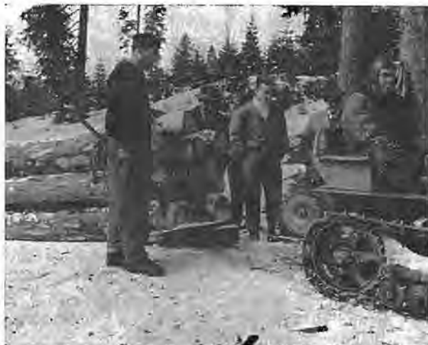
Slika 6. Pritegovanje naložene sankalne plošče z vitlom do traktorja (foto: Krivec)
