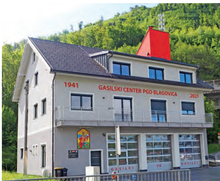
Obnovljen gasilski center.
