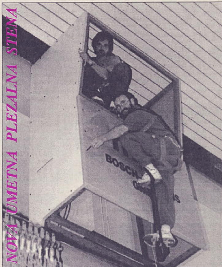
Dela na umetni plezalni steni v telovadnici OŠ Zalec so v zaključni fazi. Stena bo namenjena treningu bodočih športnih plezalcev in alpinistov ter izvedbi tekmovanj.
