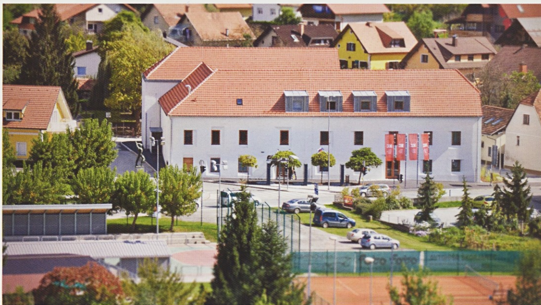
Tako izgleda prenovljeni Ipavčev kulturni center danes.
