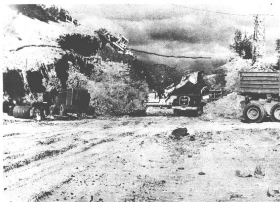
Gradnja Šaleške magistrale preko Lokovice
