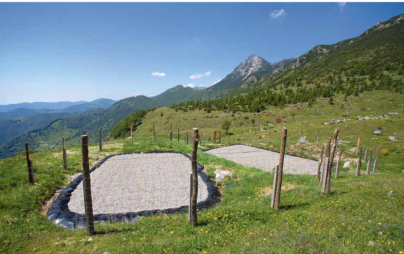
Filtrirna greda rastlinske čistilne naprave pred zasaditvijo. FOTO: IZTOK AMERŠEK
