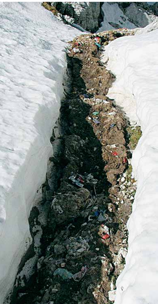
Po sezoni izpraznjena greznica – izpust gošče z vsemi "dodatki" pri koči na Doliču. FOTO: ARHIV TNP
