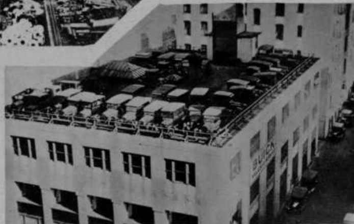
Avtogaraža na strehi.
